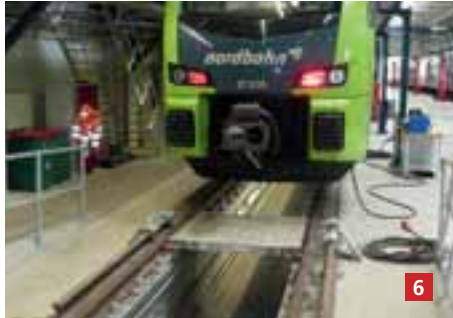
6. Gleisplatten, 2 Stück zum sicheren Überqueren der Gleisgruben
