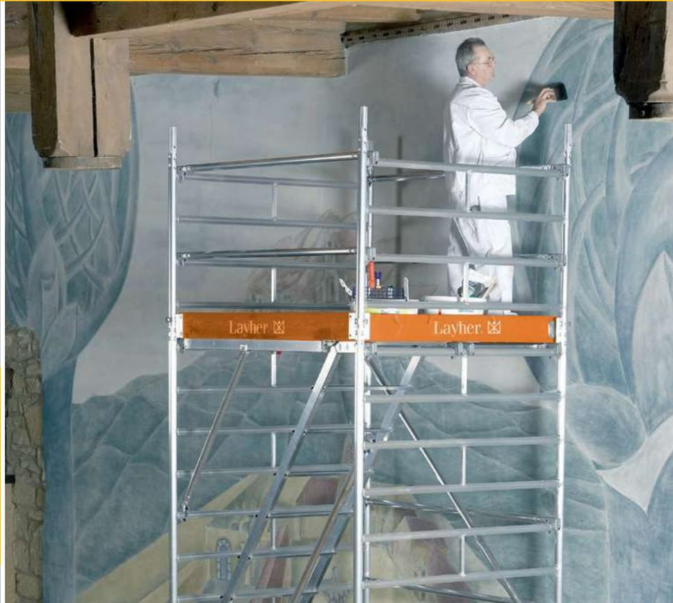
Das Uni Komfort Gerüst ist das kompakte Gerüst und beispielsweise ideal für den Monteur bei Wartungsarbeiten. Der bequeme Treppenaufstieg mit durchgehendem Handlauf begünstigt vermehrtes Auf- und Absteigen, er überbrückt leicht große Höhen und lässt die Hand frei zur Mitnahme von Werkzeug und Material.
