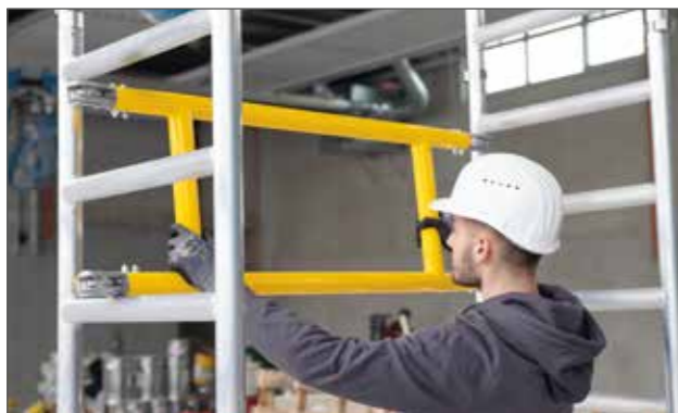
Pulverbeschichtete Geländerrahmen als Querstreben
