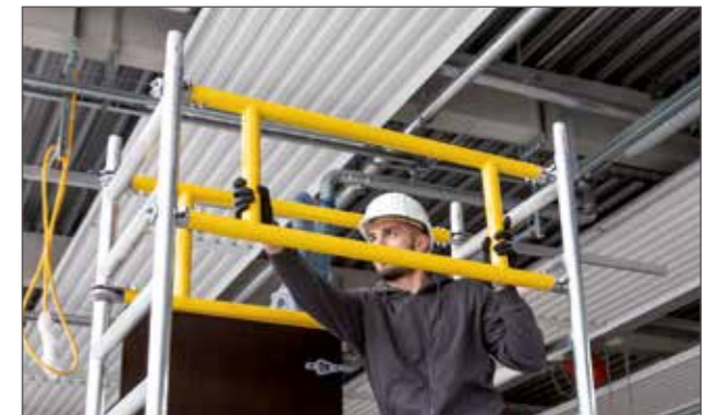
Montage im absturzesicherten Bereich dank 3-T-Methode
