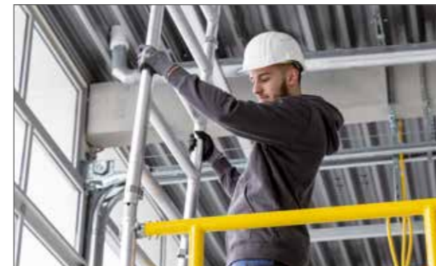
Weitere Aufsteckrahmen einsetzen
