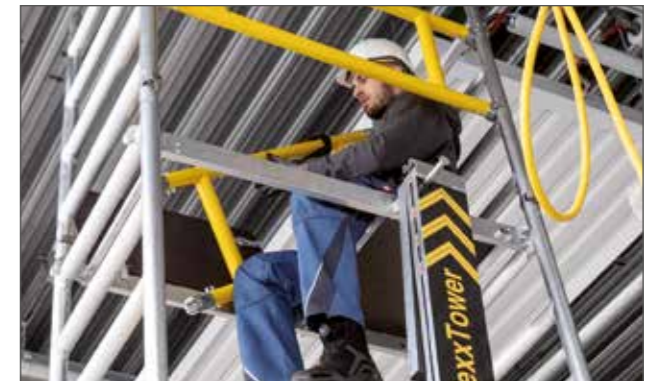
Obere Geländer und Bordbretter montieren
