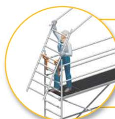
**Mit dem Sicherheitsaufbau P2:** vertikaler Plattformabstand von 2 m und integrierter, kollektiver Seitenschutz. Mehr Informationen auf Seite 54.
