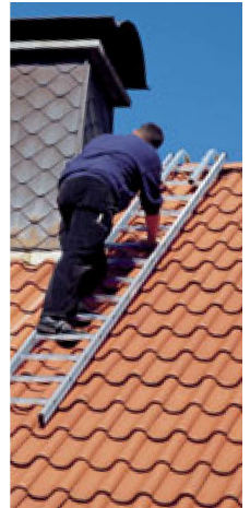
Firstüberwurfbügel mit Leiter montiert
