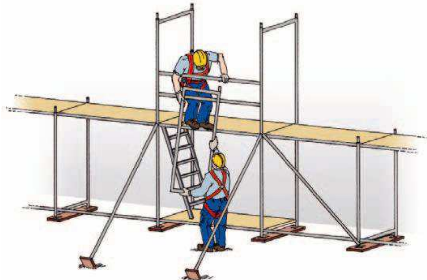
Bild 9: Beispiel für eine vorübergehende Kippsicherung der ersten Gerüstlage
