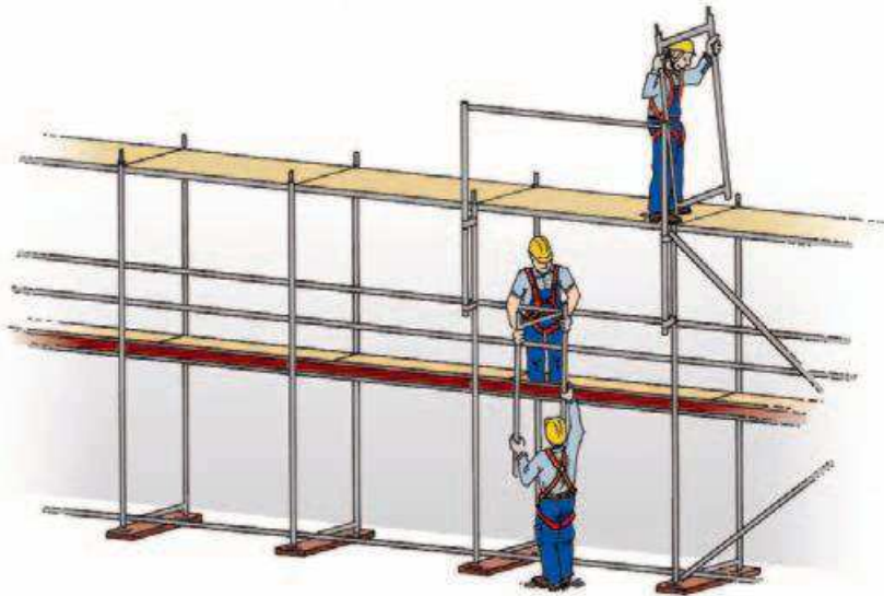
Bild 13: Montage der Gerüstlage im Aufstiegsfeld im Schutze des MSG
