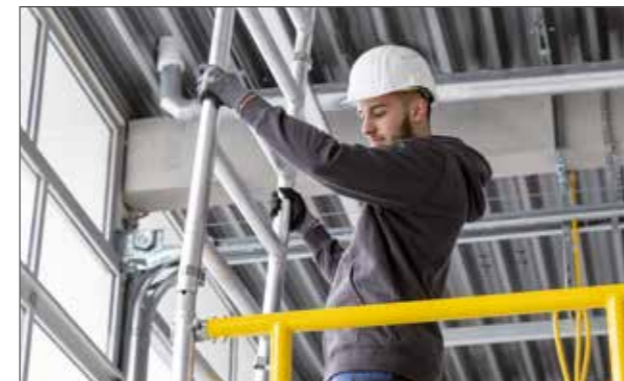
Weitere Aufsteckrahmen einsetzen
