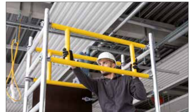
Montage im absturzesicherten Bereich dank 3-T-Methode
