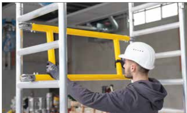
Pulverbeschichtete Geländerrahmen als Querstreben
