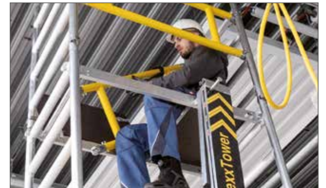
Obere Geländer und Bordbretter montieren
