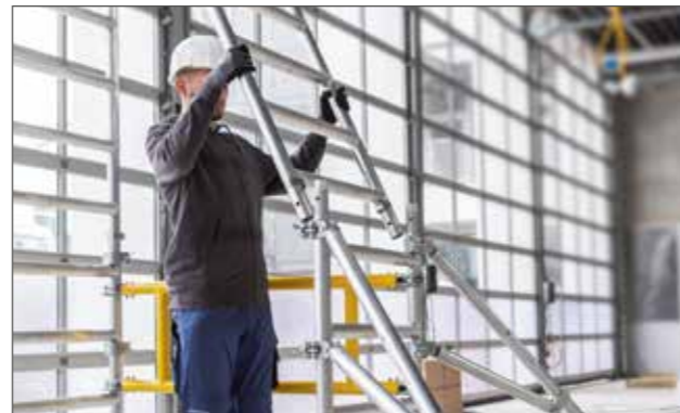
Intuitive Steckverbindungen mit Federclips
