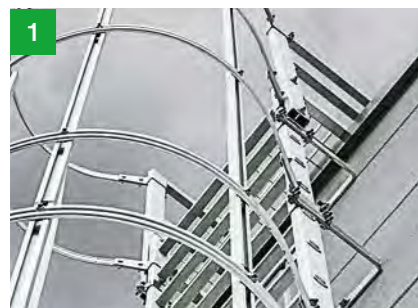
1. Ausstieg oben Für jedes Gebäude der passende sichere Ausstieg: als Ausstiegsholm (gerade oder abgewinkelt) oder als Attika-Überstieg.
