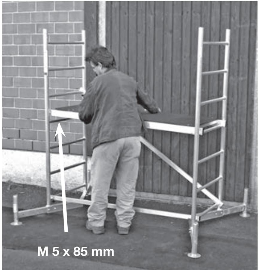
Die Abbildung zeigt das fertig montierte Grundgerüst.
