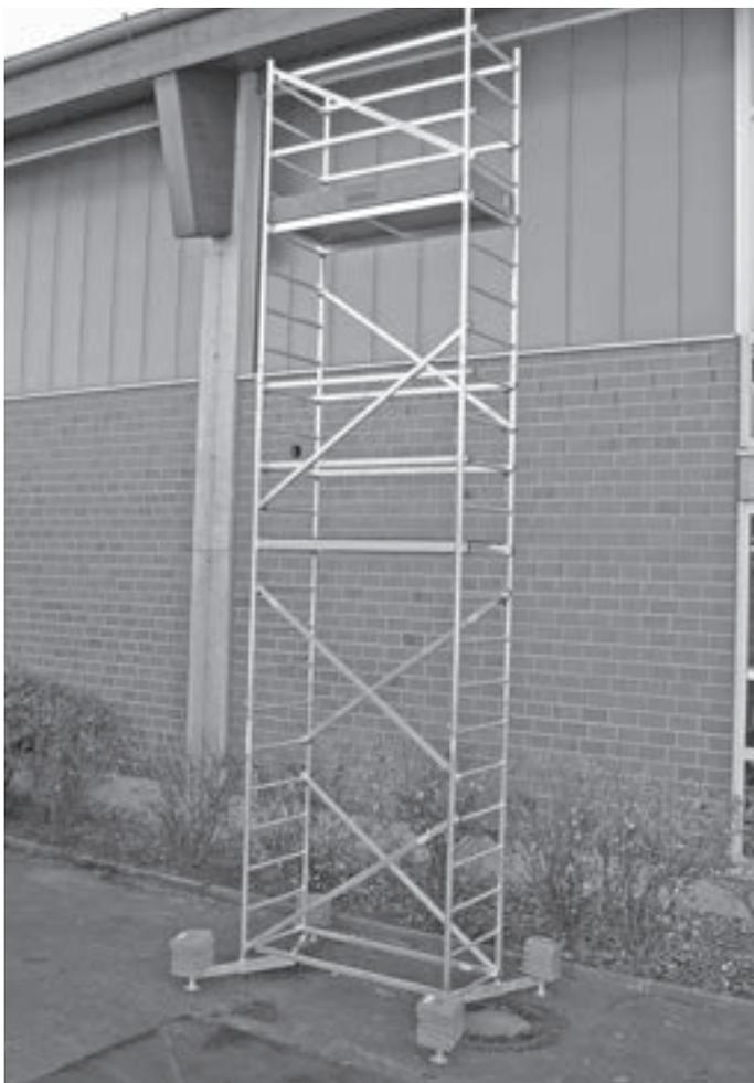
Die Abbildung zeigt das fertig montierte Gerüst mit erster und zweiter Aufstockung und 20 Ballastgewichten.
