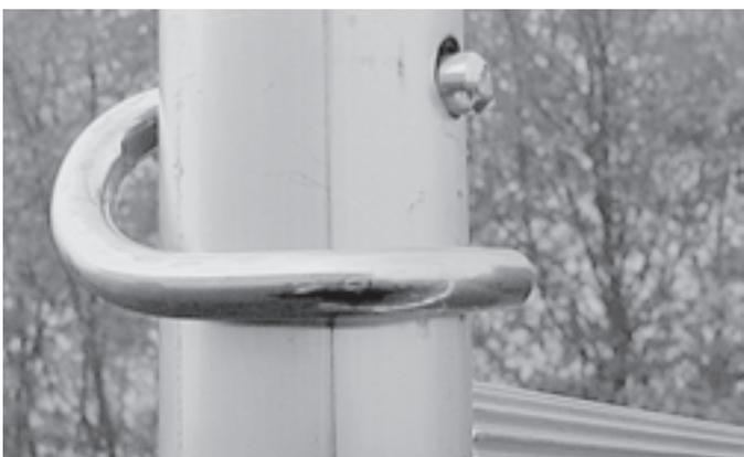
Alle Steckverbindungen müssen mit Fallsteckern gesichert werden.
