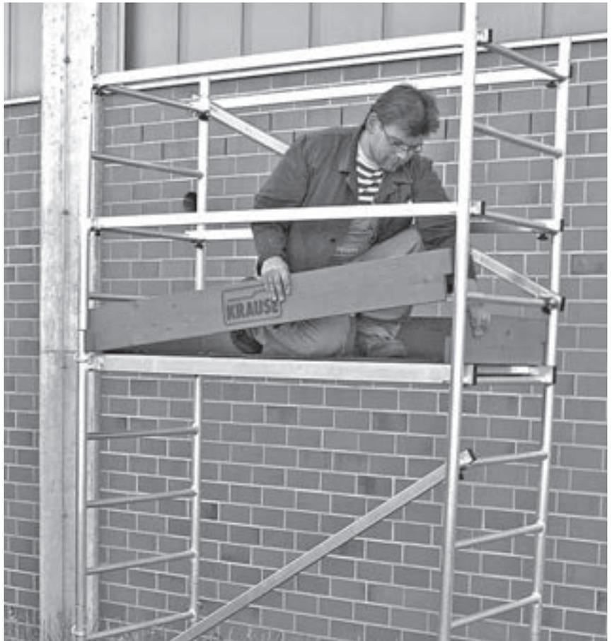
Die Abbildung zeigt den fertig montierten Seitenschutz.
